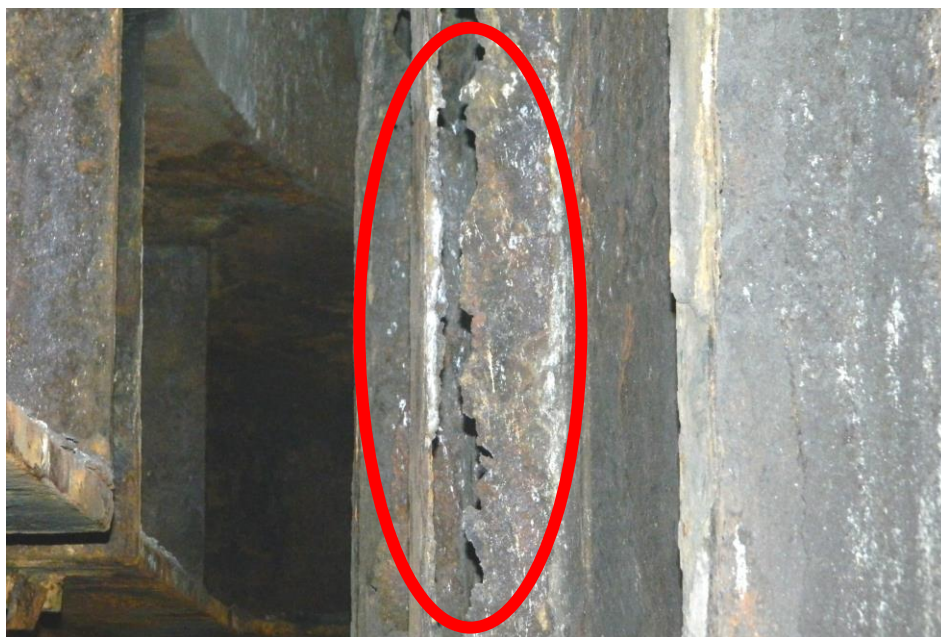
Рисунок 2.2 – Результат корозійного зносу опори поворотного стенда МБЛЗ
