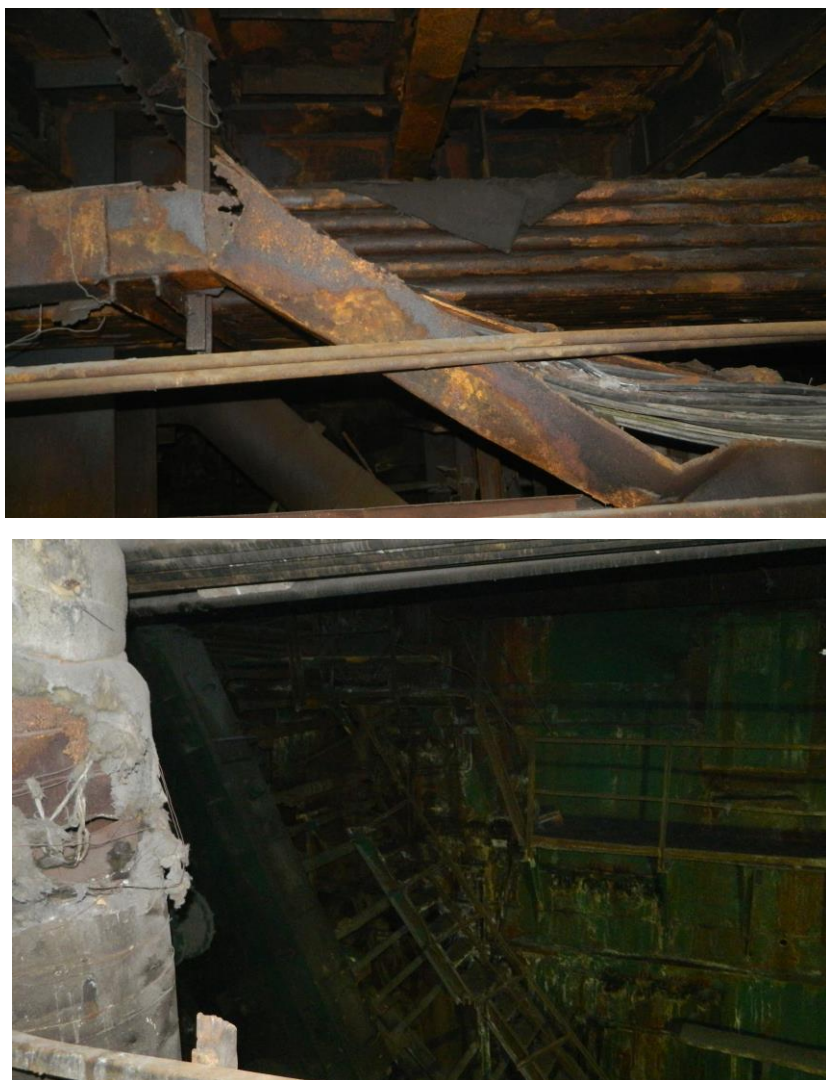
Рисунок 5.8 – Рама зони вторинного охолодження, котра схильна до корозійного зносу.
